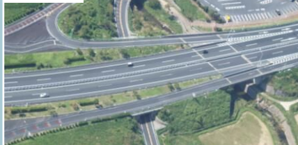
ハイウェイアス富楽里付近 付加車線設置
